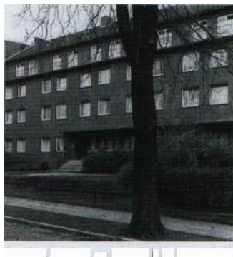
Ehemaliges Wohnheim von Beiersdorf in der Tornquiststraße (1965) Quelle: Beiersdorf AG, Corporate & Brand History
